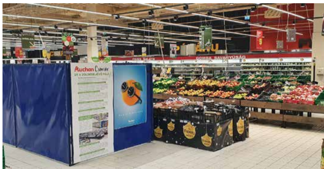
Az átépítés alatt paravánokkal takarják a munkaterületet
